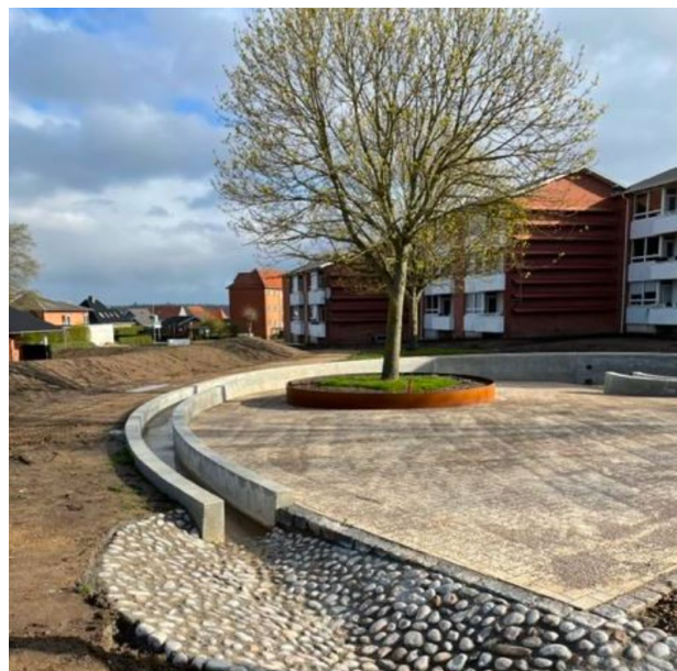
Nørgaard har utfört mark- och anläggningsarbeten för Brændkjær Climate Park
